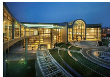
GCIP園區的節能性取決於建築設計及系統性能測試。GCIP辦公樓的項目外牆設計、鍋爐效能、照明系統均超過ASHRAE（美國採暖、製冷與空調工程師學會）的標準，且綜合耗能與美國標準相比降低18.55%，值得一提的是，耗能的電腦模擬在項目全程中得到應用以優化並監測耗能表現。
